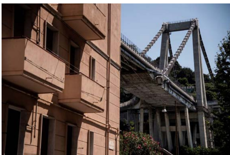
Fig. 11 - Vista della pila e dei tiranti rafforzati nel 1993. Da "il Fatto Quotidiano"
