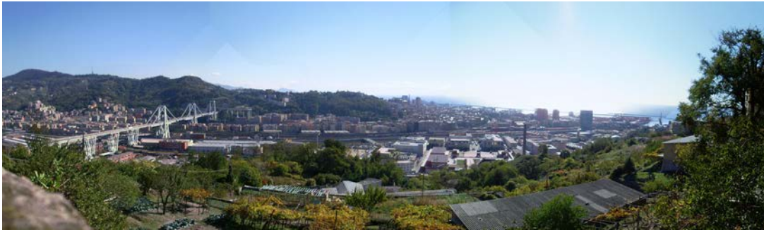
Fig. 3 - Vista dell'ambiente naturale e urbano attraversato dal viadotto sul Polcevera verso Genova (da wikipedia)
