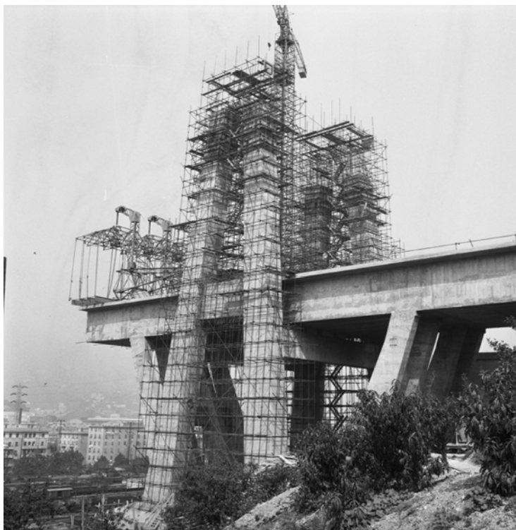
Fig. 4 - La stilata e l'antenna 11 nelle prime fasi di costruzione
