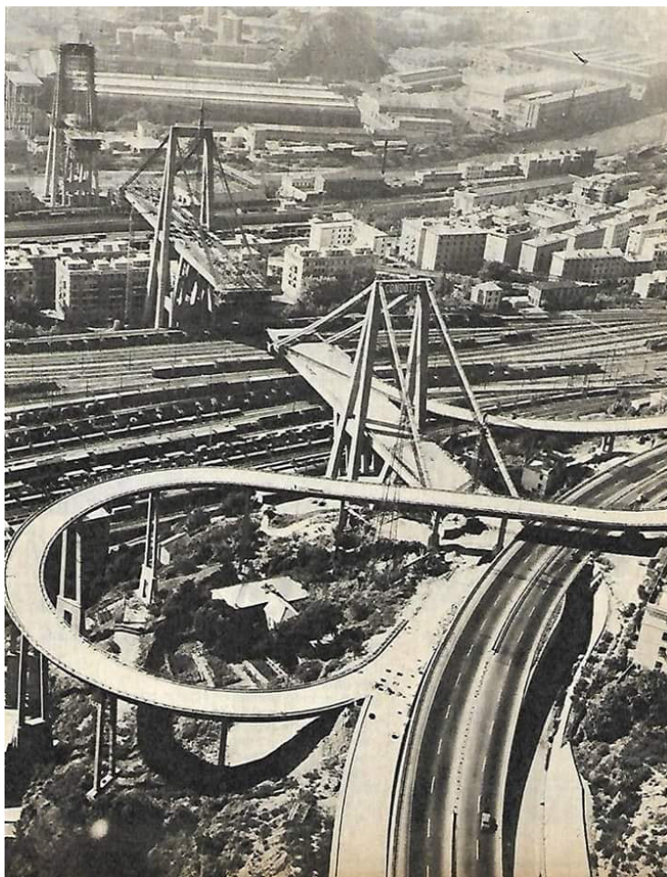
Fig. 10 - Vista da levante, si notano le rampe autostradali e il completamente della travata a sbalzo in attesa dell'arrivo della trave Gerber da 36 metri. da wikipedia
