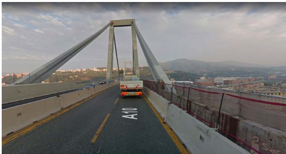
Fig. 12 - Collocazione dei Jersey senza riduzione della carreggiata, maggio 2018
