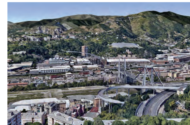
Fig.1 - Il ponte Morandi dopo il crollo 2018 e prima della demolizione totale 2019
