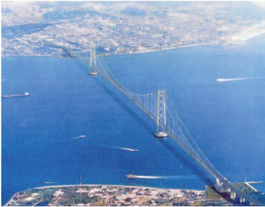
3. Veduta dell' Akashi Kaikyo Bridge, costruito in Giappone con una lunghezza della campata centrale di 1991 m, aumentata a 1991 m a seguito del terremoto di Kobe del 17 gennaio 1995, per effetto di uno spostamento orizzontale differenziale delle torri di 1,12 m
